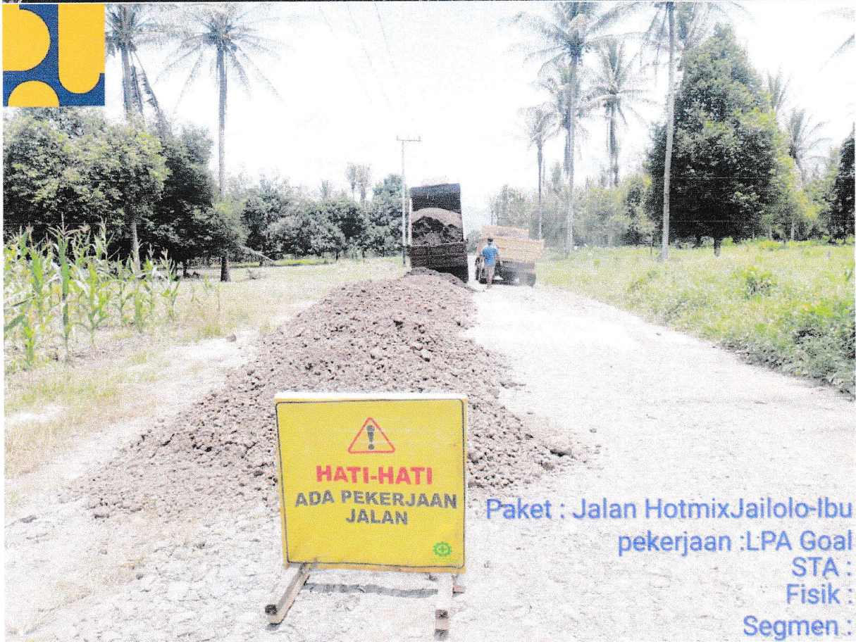
1°4'12.712" N 127°28'19.371" E PENINGKATAN JALAN RUAD DALAM KOTA JAILOLO SEGMENT SOAKONORA - GUFASA KEGIATAN ASPAL STA
